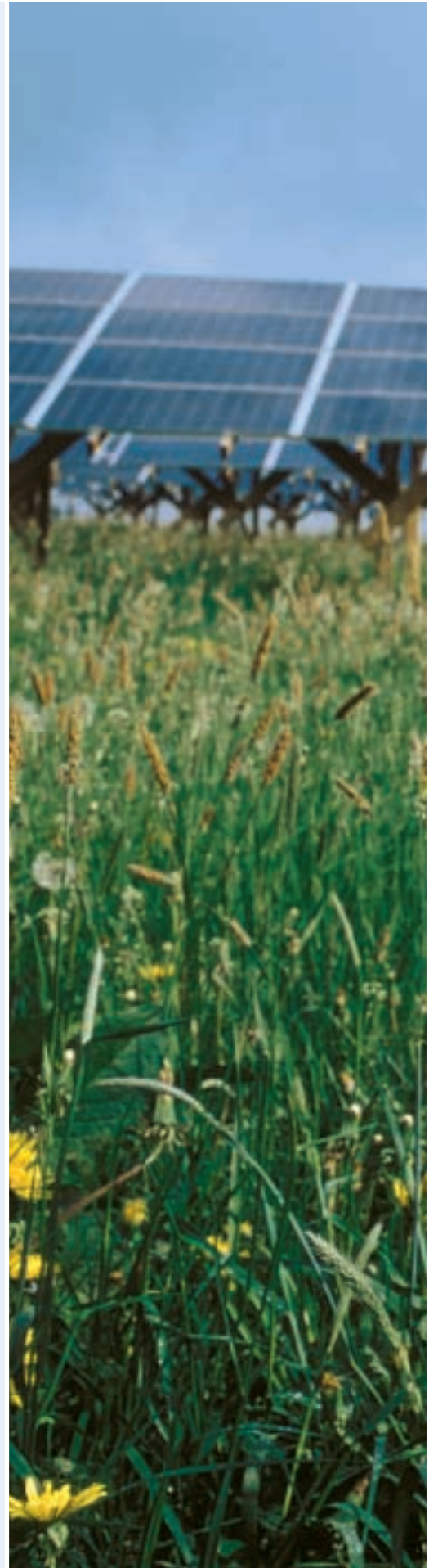
2003: Solarpark Oberötzdorf 1,7 MW
