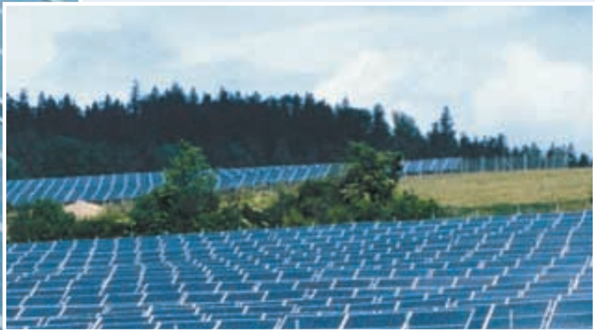
2003: Solarpark Oberötzdorf 1,7 MW
